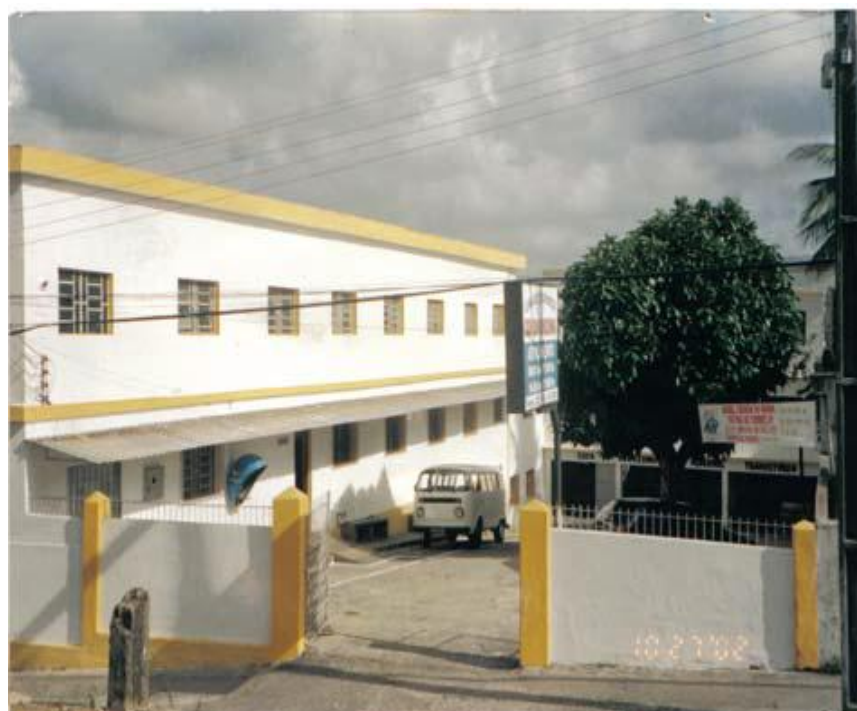
FIGURA 5– Vista do prédio atual, lateral direita da UEDAC Fonte: Acervo da UEDAC
